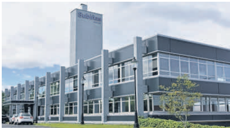
La vizcaína Matra Mantenimiento Integral ha realizado la adecuación de la fábrica
